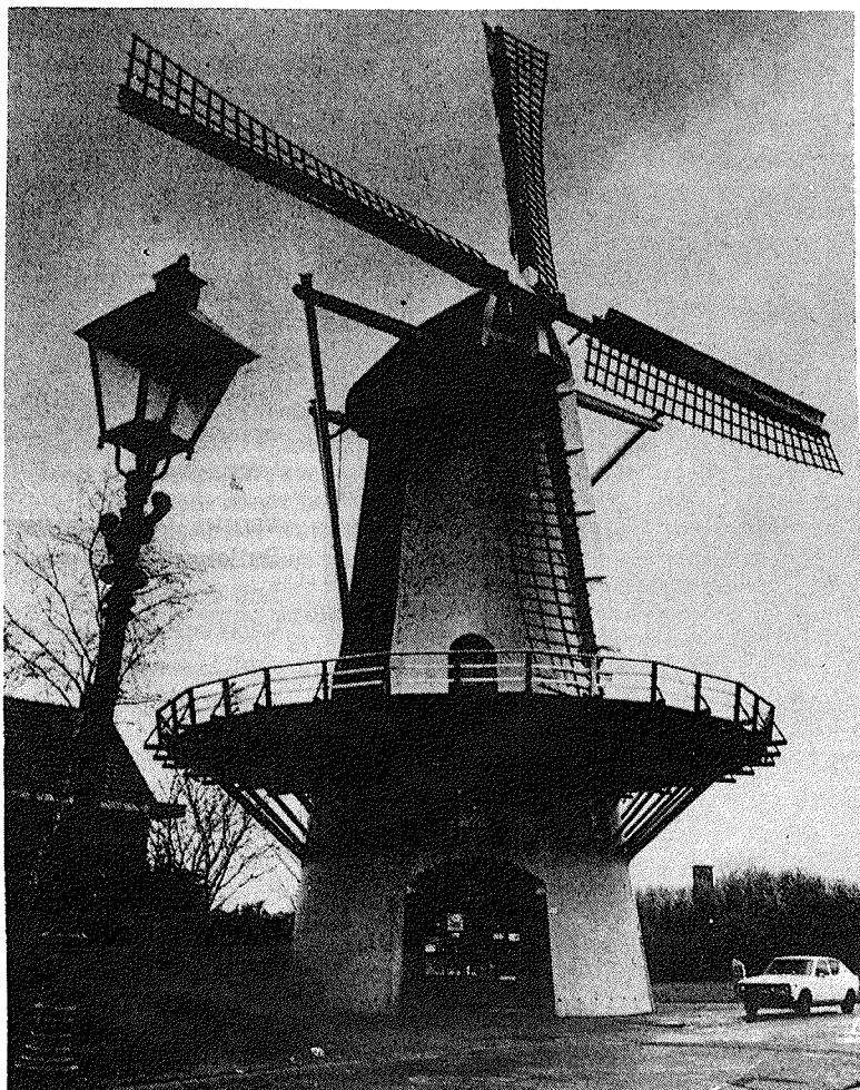
EEN YDILLISCH PLAATJE VAN DE MOLEN AAN DE KROMME ZANDWEG TE CHARLOIS
